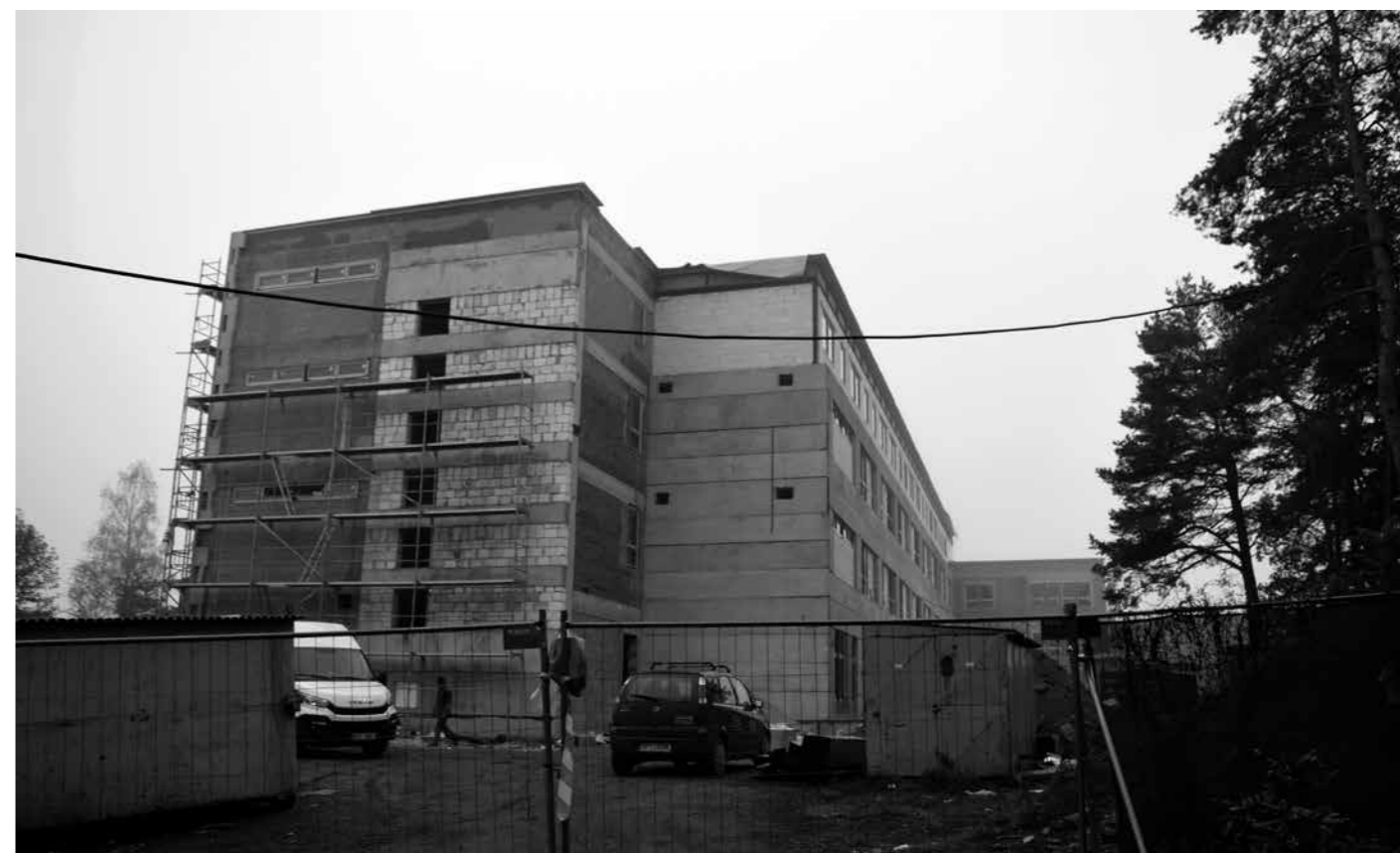
Přestavba bývalého Šumavanu je v plném proudu
